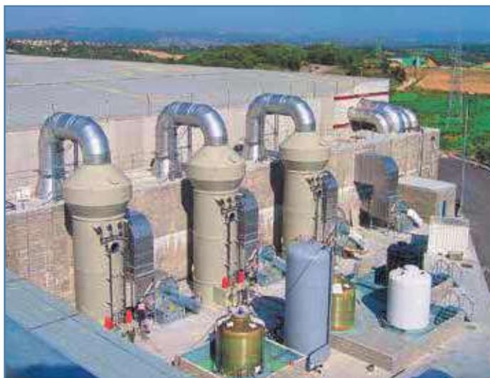
Figura 1 - Biofiltri per un impianto di trattamento rifiuti.
