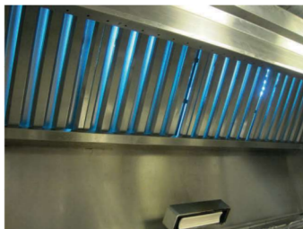
KPC-SYSTEM PER LA DEODORIZZAZIONE ALL'INTERNO DI UNA CAPPA
