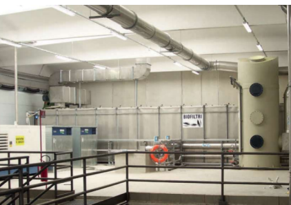
IMPIANTO DI BIOFILTRAZIONE (Q 10.000 M 3 /H)
